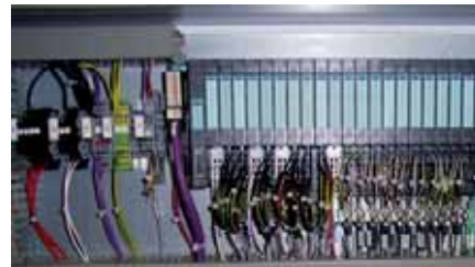
< Schaltkasten mit Steuerung Simatic S7™ (SPS)
